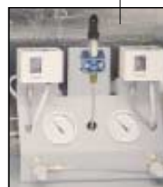
Controlli di pressione e trasduttore. Pressure controllers and transducer.
